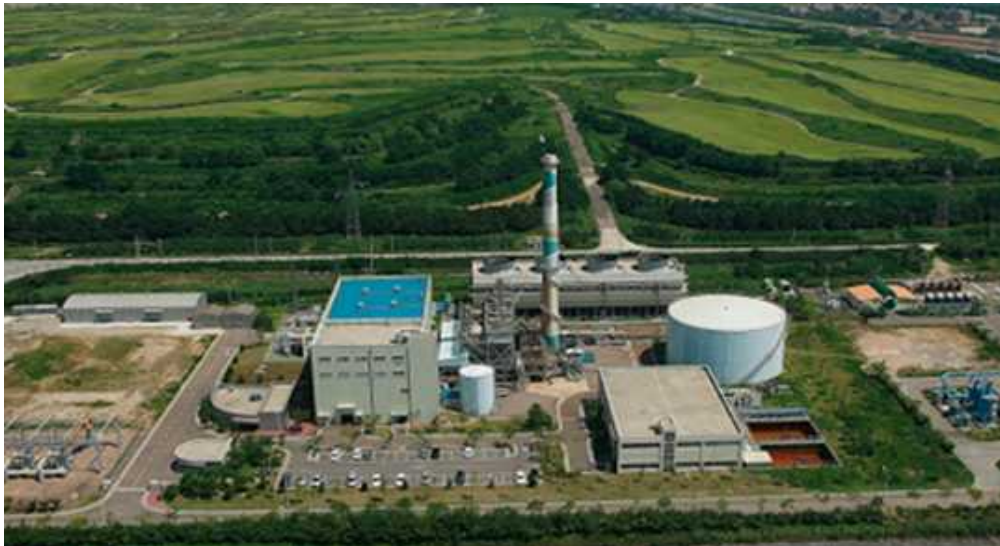
<図 2> 首都圏埋立地の埋立ガス発電所 (50Mw)
