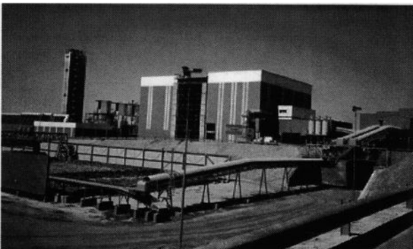
スペインマドリッド市ごみ焼却プラント（660トン/日）
