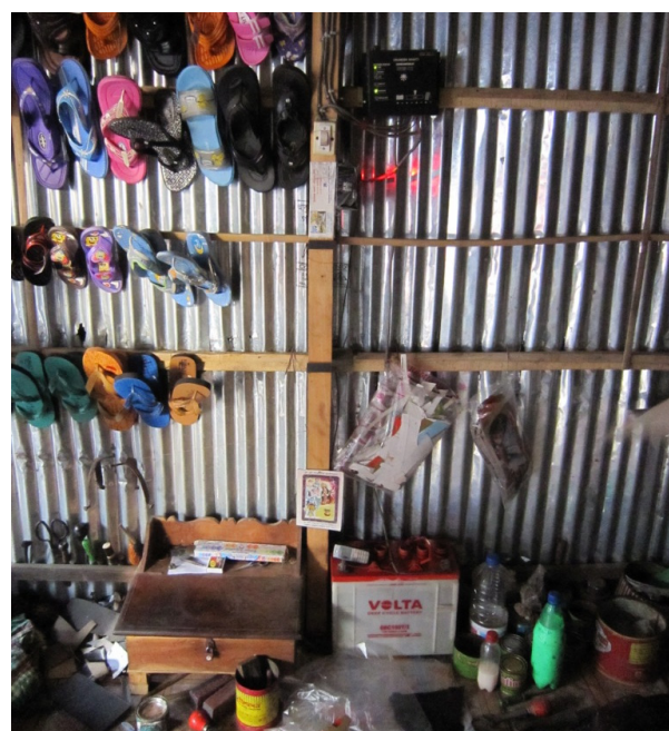
写真2 マイクロユティリティーシステムの所有者(靴屋)のチャージコントローラーと蓄電池
