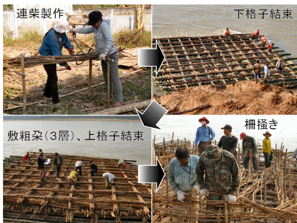
(左) メコン河に浮かべた竹製の筏上での粗朶沈床製作工程 (右) ボケオ県で初めて完成した粗朶沈床。この後、筏を下流方向に引き抜き、碎石を投入して河床に沈める。
