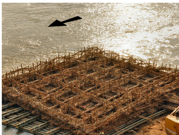
(左) メコン河に浮かべた竹製の筏上での粗朶沈床製作工程 (右) ボケオ県で初めて完成した粗朶沈床。この後、筏を下流方向に引き抜き、碎石を投入して河床に沈める。
