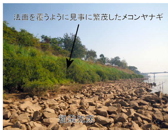
開発調査においてビエンチャン市に建設した河岸侵食対策工 —根固工に粗朶沈床、法面保護工に栗石粗朶工を採用—
