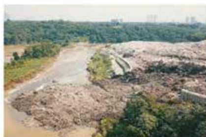
インドネシア南タンゲラン市 埋立処分場の崩落 (2020年)
