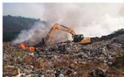
インドネシア西バンドン県 埋立処分場の火災 (2019年)
