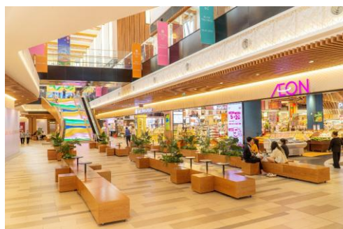
調光調色型高効率LED照明 (遠藤照明)
